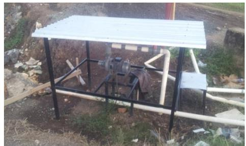
Gambar 46. Pemasangan Instalasi Listrik untuk Pengairan TSP.
